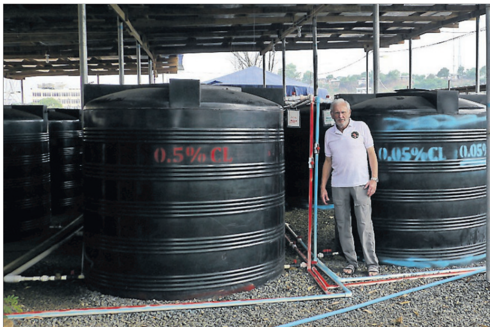
Große Tanks mit Trinkwasser und zwei unterschiedlich starken Chlorlösungen zur Desinfektion von Händen und Gegenständen: Jeden Tag werden bis zu 10 000 Liter verbraucht. Fotos: privat
